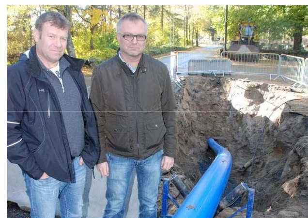
Hans Stormo (t.v.) på bydrift og prosjekterende Rune Danneborg kjenner bakken rister når det blå plastrøret, som er ekstra beskyttet, trekkes inn i det gamle asbestrøret.
