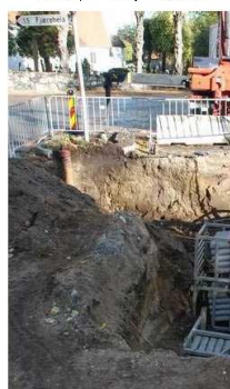
Jekk. Her står jekken nede i hullet og sørger for å trekke med 180 tonn for å få det nye
